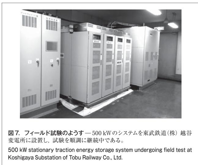
図7. フィールド試験の様子 — 500 kWのシステムを東武鉄道(株) 越谷変電所に設置し、試験を順調に継続中である。
