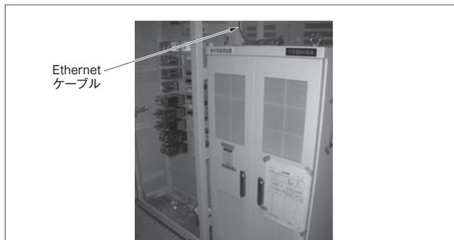
図6. 現地に据え付けられた中間LC — 信号機器室内に据え付けられる省スペースなきょう体で、Ethernetケーブルで外部と接続される。
