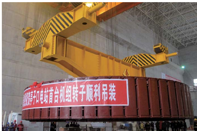
亭子口発電所の発電機回転子
