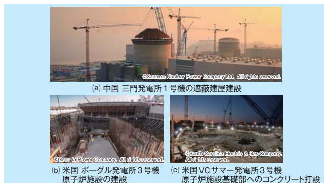
中国及び米国での建設状況
