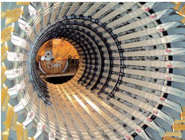
ウェストン火力発電所3号機発電機の固定子コイル巻替
