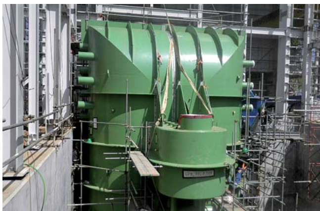
軸流排気スプレー式復水器の据付け
