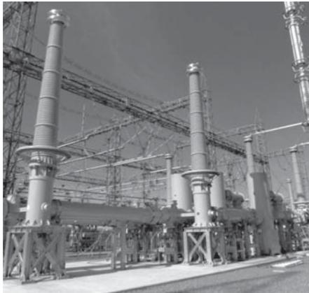
図5. 中部電力(株) 西部変電所 550 kV GCB及びGIS — 2013年3月に納入し、同年6月から運転を開始した。
