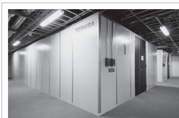
図1. 屋内モジュール型データセンター — 省エネ、省スペース、高セキュリティ、及びBCPを実現する。
