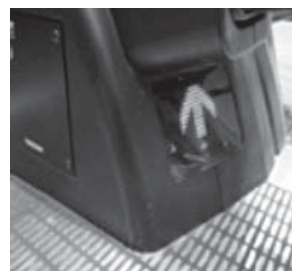
図9. 運転モニタ ESNAVI™ — 矢印と進入禁止マークを表示し、エスカレーターの運転方向が一目でわかるようにしている。 ESNAVI™ operation monitor
