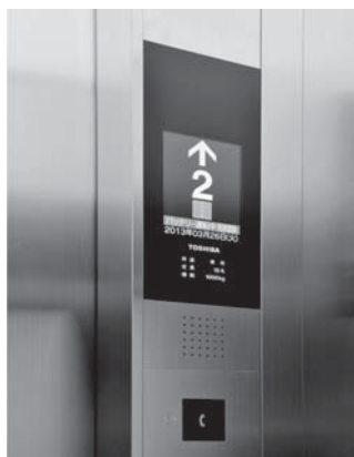
図7. 来客用エレベーターの停電時継続運転表示画面 — 大型の液晶画面を採用し、管制運転など様々な情報を表示している。 Indicator in passenger elevator for guests showing continuous operation during power blackout
