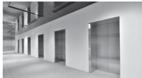
図1. 乗用エレベーター(3階ホール) — 24人乗りエレベーターが合計24台設置されている。
