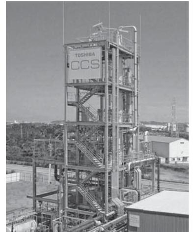
図9. CO<sub>2</sub>分離回収パイロットプラント — CO<sub>2</sub>回収の長期試験を継続中である。
