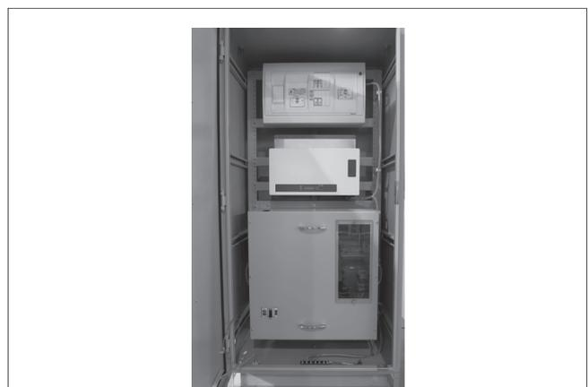
図6. 電気・制御システム屋内収納盤 — 屋内収納盤 (800 (幅) × 500 (奥行き) × 1,600 (高さ) mm) には、上から住宅用分電盤、系統連系PCS、及び水車制御ユニットが収められている。
