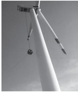
図8. ナセルクレーンを用いた部品交換 — 2 MW機は、外部の大型クレーンを用いることなく、発電機を含むナセル内部品の交換が可能である。
