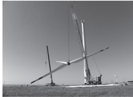
図9. ローターの据付け — ウクライナ建設プロジェクトにおいてロータを据え付けているときのようすである。
