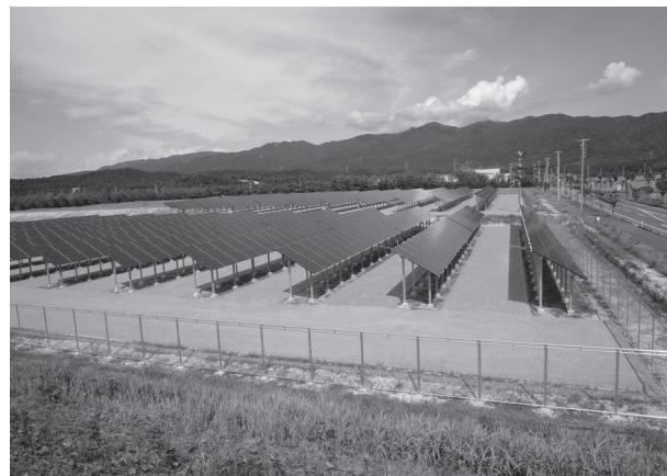
図1. 新潟東部2号系列 — 積雪地域特有の配慮や、短い日照時間への対策を取り入れた、雪国型のメガソーラーシステムである。
