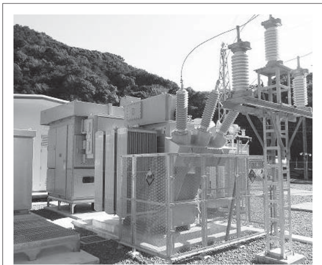
図1. 液体シリコン変圧器 — 変圧器冷却媒体に液体シリコンを採用することで、環境対策と変圧器の小型・軽量化を実現した。 Silicone-liquid-immersed transformer
