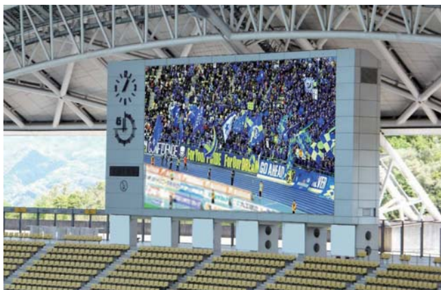
改修工事後の大型映像表示装置
