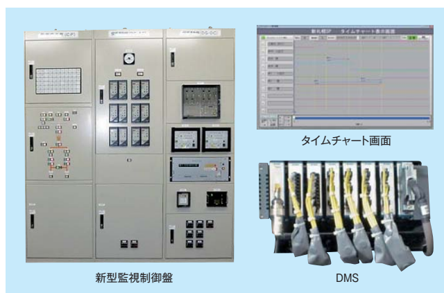
新型監視制御盤とDMS
