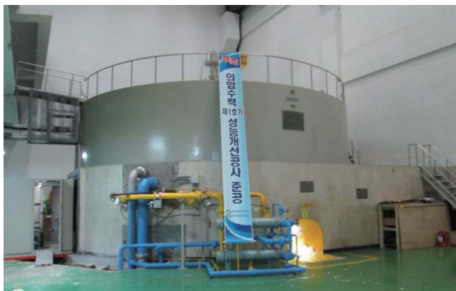
衣岩水力発電所の1号水車発電機
