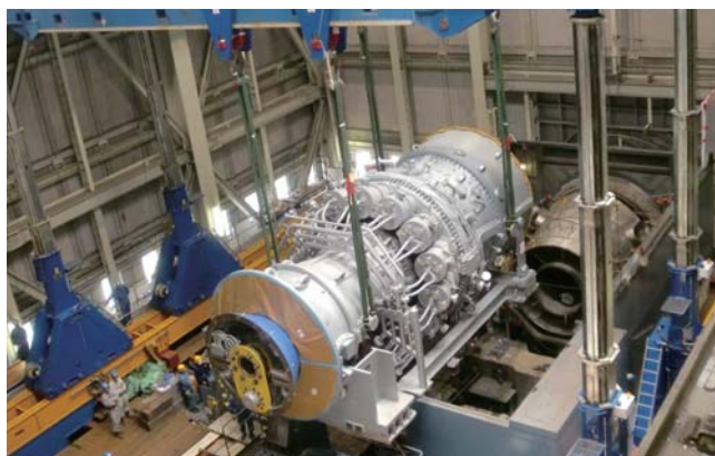
ガスタービンの据付け
