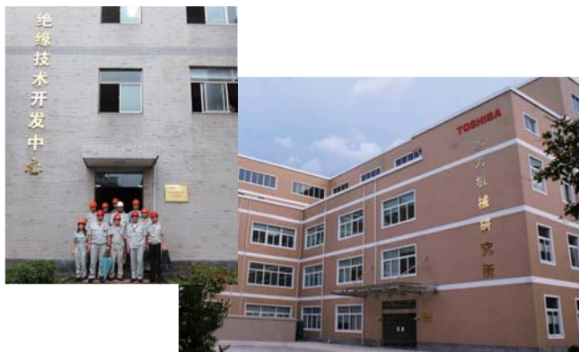
絶縁技術開発センター開所式と水力機械研究所
