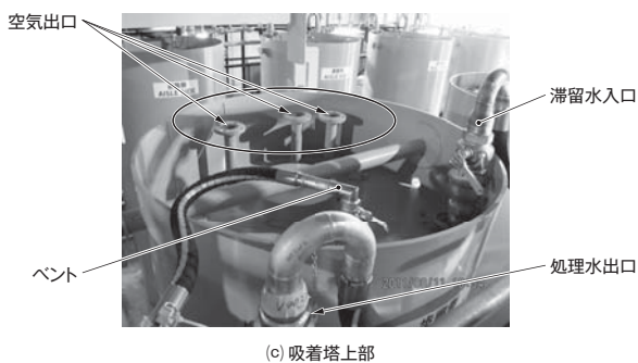
図4. SARRY™ 吸着塔の概要 — 吸着塔は、吸着したCsの崩壊熱に耐え、水の放射線分解で発生する水素をベント除去し、被ばく線量を低減するための鉛遮へい材を周辺に設けた。 Outline of SARRY™ vessel for second wastewater treatment system
