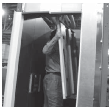
図8. 側板のかご内組立て— SPACEL-GR™以降、かご室を構成する側板をかご内で組み立てられるようにして作業性を向上させた。 Sidewall construction within a cage
