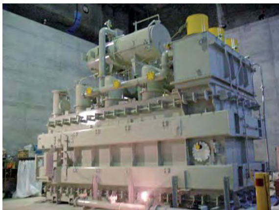
275 kV 分解輸送現地組立形変圧器
