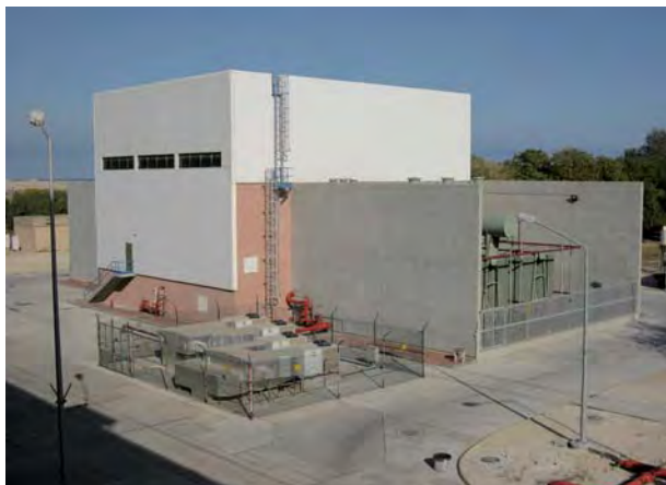
完成した新直列リアクトル建屋の全景
