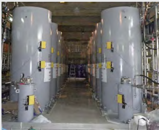
▲ 汚染水処理システム SARRY™ SARRY™ contaminated-water treatment system
