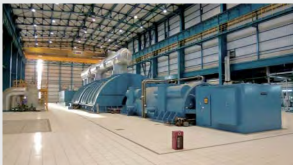
▲ 蒸気タービン及び発電機 Steam turbine and generator
