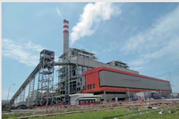
▲ タンジュンジャチB 3・4号機 蒸気タービン・発電機建屋全景 Tanjung Jati B Units 3 and 4 steam turbine and generator building
