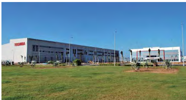
工場と本社ビル (東芝ジェイエスダブリュータービン・発電機社)
