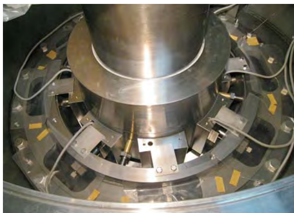
水車軸受の現地組立状況
