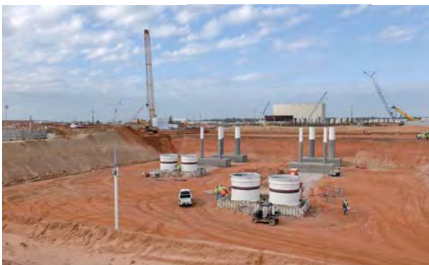
(b) ボーグル3、4号機の建設準備工事
