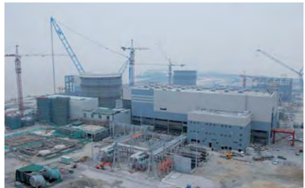
(a) 中国 三門発電所 1号機の建設現場
