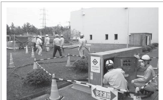
図2. 仮設備へ給電するための仮電源設置の様子 — 汚水のくみ上げのために、仮設の高圧受電盤を設置して仮設水中ポンプの電源を確保した。
