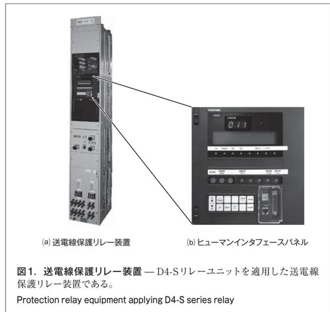
長とした新しい保護リレー装置である。実際の電力系統への適用としては、2010年8月に1号機を納入した。D4-Sリレーユニットを適用した送電線保護リレー装置の外観を図1に示す。
