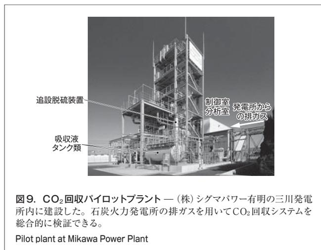
図9. CO<sub>2</sub>回収パイロットプラント — (株)シグマパワー有明の三川発電所内に建設した。石炭火力発電所の排ガスをういてCO<sub>2</sub>回収システムを総合的に検証できる。
