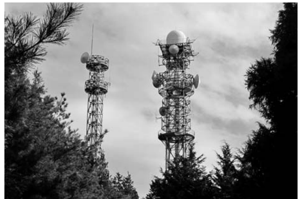
図1. X帯固体化気象レーダの設置状況 — レーダは、近畿地方整備局の鷺峰山無線中継所の鉄塔上部に設置されている。
