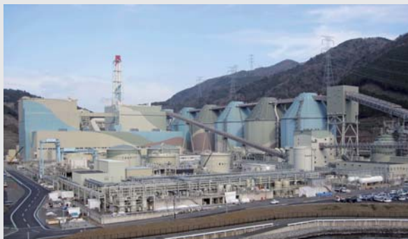
▲ 舞鶴発電所2号機 Maizuru Power Plant Unit No. 2
