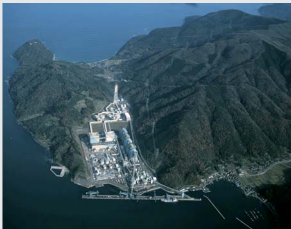
▲ 関西電力(株) 舞鶴発電所 Overview of Maizuru Power Plant of The Kansai Electric Power Co., Inc.
