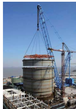
(b) 三門発電所1号機 格納容器の4段目リング据付け(2010年9月)
