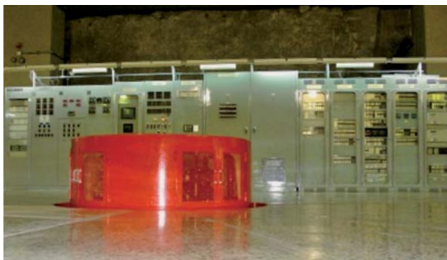
固定子コイル更新後のサンカルロス発電所6号発電機
