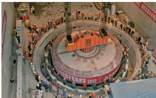
深溪溝発電所1号機のロータつり込み風景
