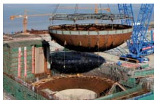
(a) 三門発電所1号機 格納容器のボトムヘッド据付け(2009年12月)
