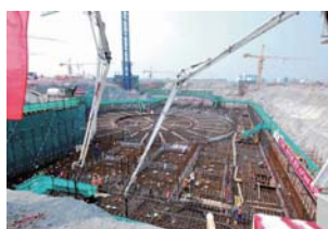
(c) 海陽発電所2号機着工(2010年6月)
