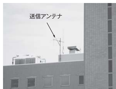
(b) 送信アンテナの設置状況
