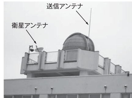
(b) 送信アンテナの設置状況
