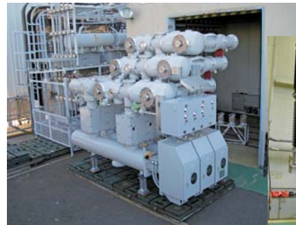
New 245 kV GIS
