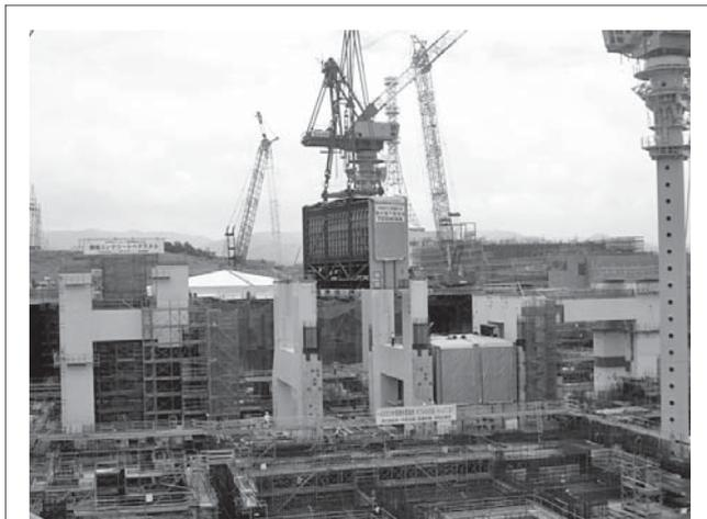
図2. 復水器(下部)の据付け—大間発電所で復水器(下部)を据え付けているようすである。
