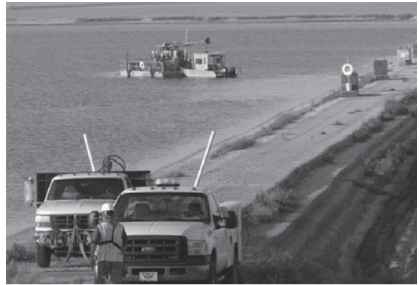
図7. 冷却池でのボーリング調査工事 — STP-3/4建設現場では、2009年9月から準備工事が始まっている。
