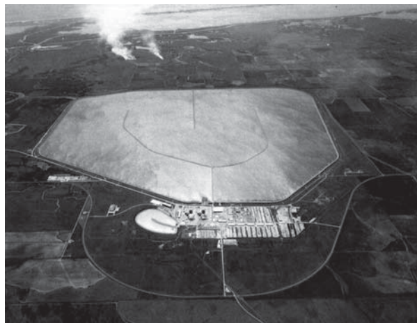
図1. サウス テキサス プロジェクト原子力発電所 — テキサスの大平原にあるこの発電所は、冷却水を確保するための広大な人工池が特徴的である。 South Texas Project (STP) nuclear power plant
