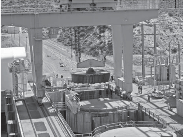
図4. ウェルズ発電所 — 低落差で大容量の発電機を採用した水力設備で、北米に多い、建屋を持たない屋外型の発電所である。 Wells Hydropower Station, U.S.A.
