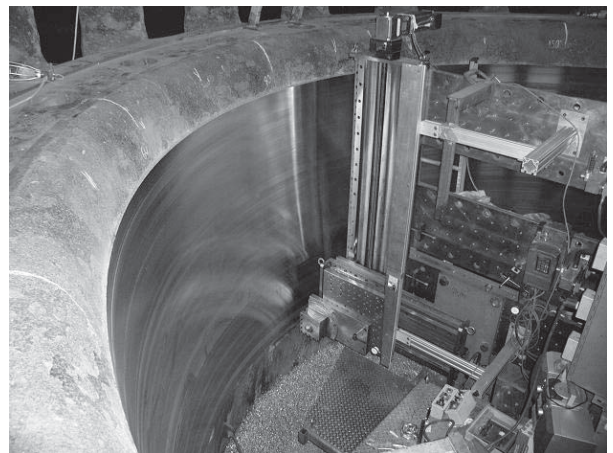
図6. ディスチャージリング内面の現地加工技術 — 強力な加工設備により高精度な現地加工が行われている。 Precision on-site machining technology for discharge rings
