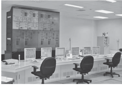
図1. プルリア発電所のSCADAシステム — 3台のコンピュータを使用した冗長システムで、操作卓のデュアルモニタと大型スクリーンに画面を表示することにより、オペレーター間で情報の共有ができる。
