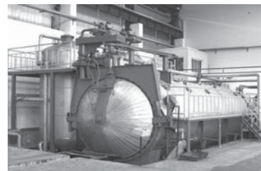
図4. THPCの製造設備 — 液圧レジニッチ絶縁コイル製造用の真空タンク設備であり、真空タンク内でレジニッチ絶縁コイルを加熱含浸させ、信頼性の高いステータコイルを製造できる。
