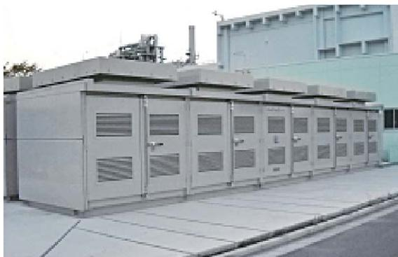
1,000 kW NAS 電池システム
