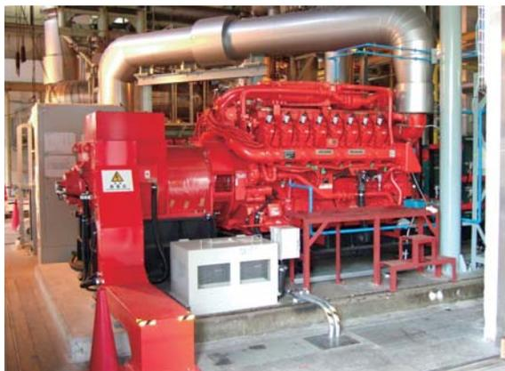
バイオガスエンジン発電システム
