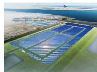
(b) (仮称)浮島太陽光発電所
