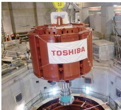
ボゴング発電所の発電機回転子 Generator rotor for Bogong Power Station, Australia
