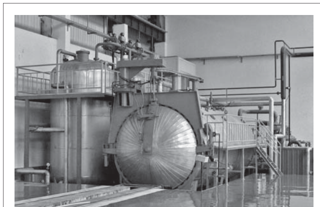
図8. VPRコイル製造用真空タンク設備 — 真空タンク内でレジンリッチ絶縁コイルを加熱、液圧硬化させ、信頼性の高いステータコイルを製造する。 Vacuum tank facility for manufacturing high-quality resin-rich insulated coils
