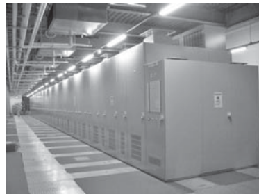
図6. 東海旅客鉄道(株) 沼津周波数変換装置 — 周波数変換装置の開発により、東海道新幹線に安定電源を供給し、その安定運行に寄与している。
