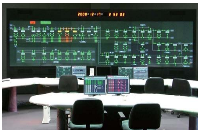
東武鉄道 (株) 電力管理システム Supervisory control and data acquisition (SCADA) system for power supply systems of Tobu Railway Co., Ltd.
