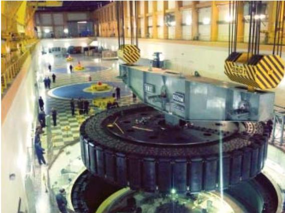
イラク モスル第一発電所改修工事中の4号発電機
