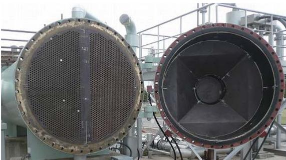
海水熱交換器の海水接水面への実装状況
