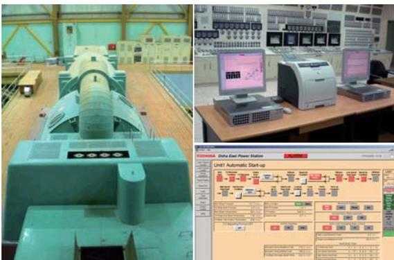
クウェートドーハイースト発電所の蒸気タービン、EHCオペレータステーション、及び自動起動画面
