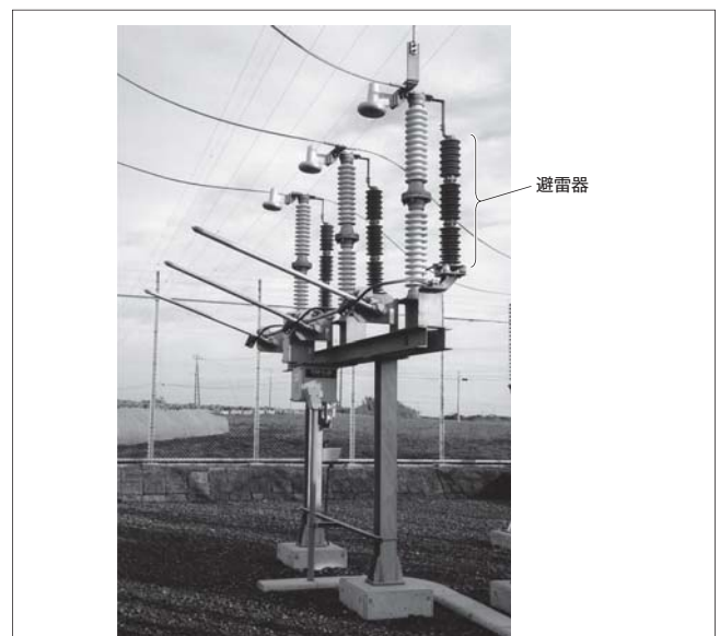
図13. 66 kV用ポリマー形避雷器(モールド形、汚損地区用) — 軽量のモールド形ポリマー形避雷器は簡単なアームに取り付けができ、レイアウトの自由度が高まる。
