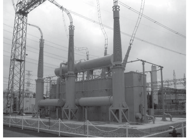
図10. ASA変圧器の現地据付 — 全天候型中身組立工法を初めて適用した東京電力(株)新所沢変電所向け525 kV-1,000 MVA変圧器は、2008年6月に運転を開始した。
