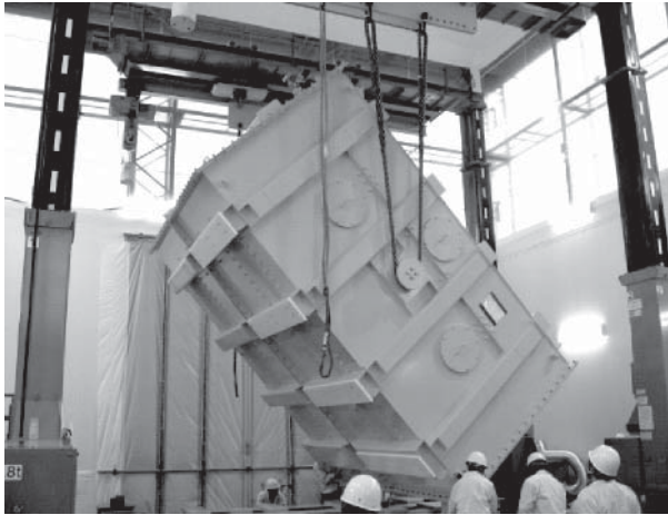
図8. 門型リフタによる鉄心起立状態 — 門型リフタだけで鉄心を起立できるため、従来の1/4のスペースで済み、作業の高さが10m以内でよい。
