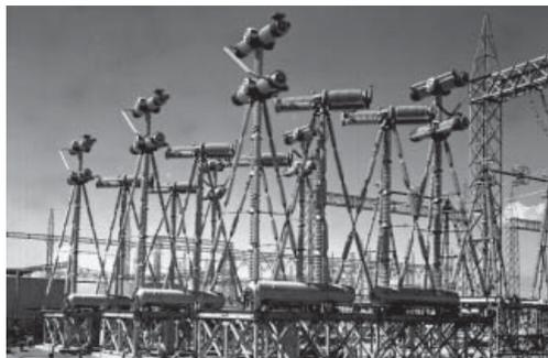
図1. 東京電力(株)房総変電所のABM形ABB — 碍子で構成されたABBの外観である。下部のタンクに操作用の圧縮空気を封入している。
