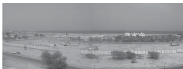
(a) 工事開始直後(造成・整地)
