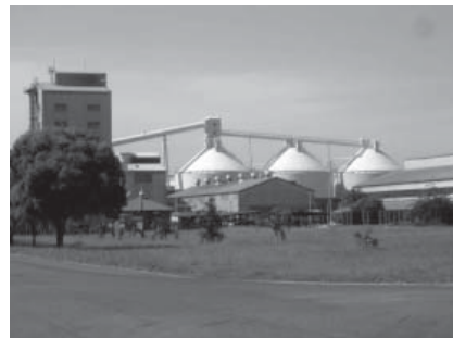
図2. クアラタンジュンのアルミ製錬所 — アルミ製錬は、510基の電解炉が操業率98%で稼働しており、約400 MWの電力を消費している。
