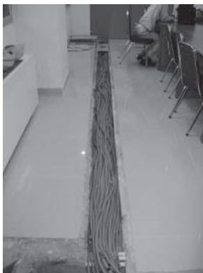
図6. シグラグラ水力発電所における新設ケーブル敷設のようす — 既設ケーブル用のピットがいっぱいだったため、新設ケーブル敷設用のピットを新たに設けた。
