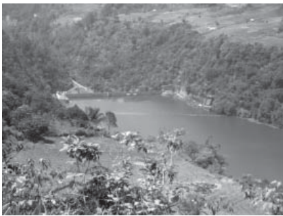
図1. シグラグラ水力発電所の貯水ダム — アサハン川のシグラグラ滝に建設された常時出力426 MW、最大出力513 MWの水力発電所である。
