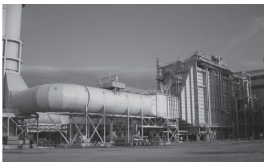
(b) 屋外設備 (HRSG、煙道)
