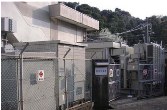
電気鉄道用 移動型コンパクト変電所 Movable compact type substation system for electric railways
