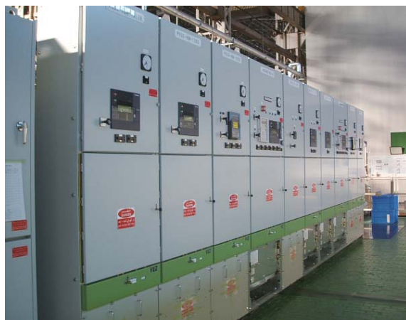
中近東向け 15 kV スイッチギヤ 15 kV switchgear for Middle Eastern market
