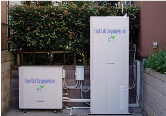
家庭用 1 kW 級 燃料電池システムの設置例 1 kW-class residential fuel cell system
