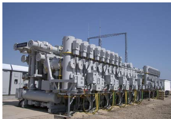
ルーマニア ブラジベスト変電所の245 kV GIS 245 kV gas-insulated switchgear (GIS) at Brazi Vest Substation, Romania
