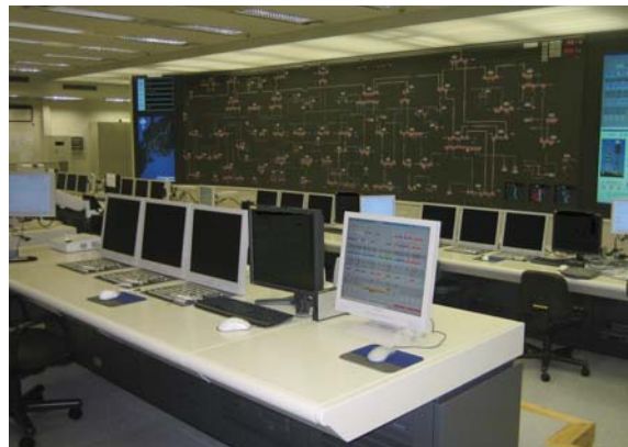
基幹給電制御所システム Central load dispatching control system of Chubu Electric Power Co., Inc.
