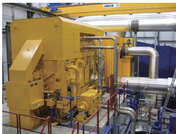
ヘリシェイディ地熱発電所の33.6 MW蒸気タービン・発電機 Turbine and generator set for 33.6 MW Low-Pressure Unit of Hellisheidi Geothermal Power Plant, Iceland
