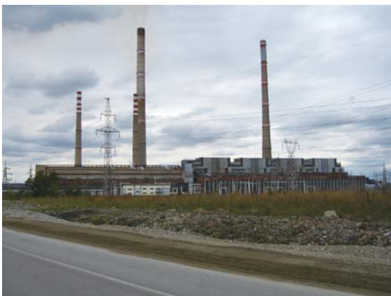
マリツァイーストⅡ石炭火力発電所 Maritsa East II Coal-Fired Power Plant, Bulgaria
