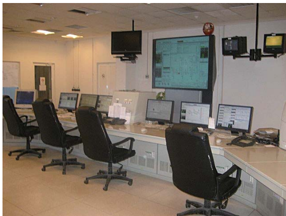
パロセニ火力発電所向け TOSMAP-DS™ のオペレータステーション
