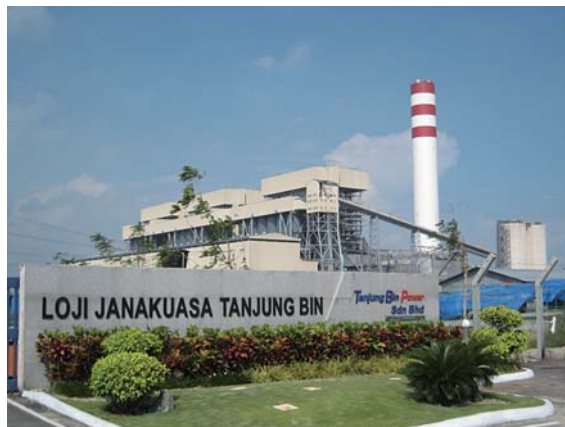
マレーシア タンジュンビン発電所 Tanjung Bin 3×700 MW Coal-Fired Power Plant, Malaysia
