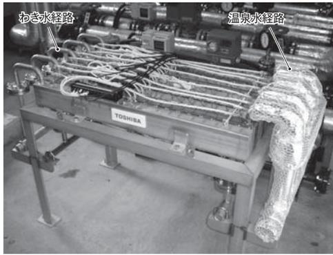
図7. 温泉とわき水との温度差で発電する温泉発電システム — 温泉熱を利用した熱電発電システムを開発し、群馬県草津町で稼働中である。運転時間は20,000時間、総発電量は1,000 kWhに達している。
